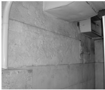
アスベストが使用されている議場冷房用機械室
