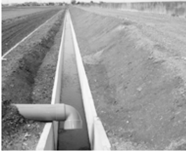
平成17年度に整備された排水路
