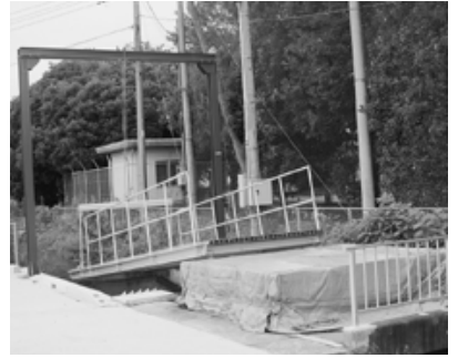
新たに設置された除塵機
