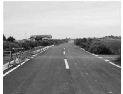
整備が進められている市道106号線
