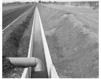
農村総合整備事業で整備された排水路
