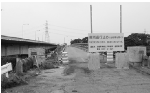
平成21年3月に全面通行止めになる旧長塚橋
