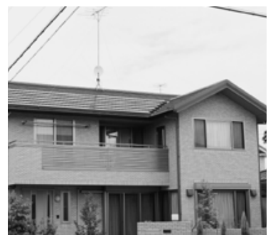
太陽光発電システム設置住宅
