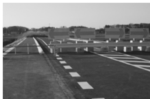
現在進められている道路整備事業 (南原平川戸線)
