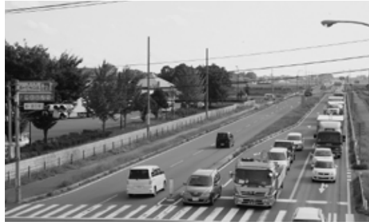
4車線化が進む国道294号
