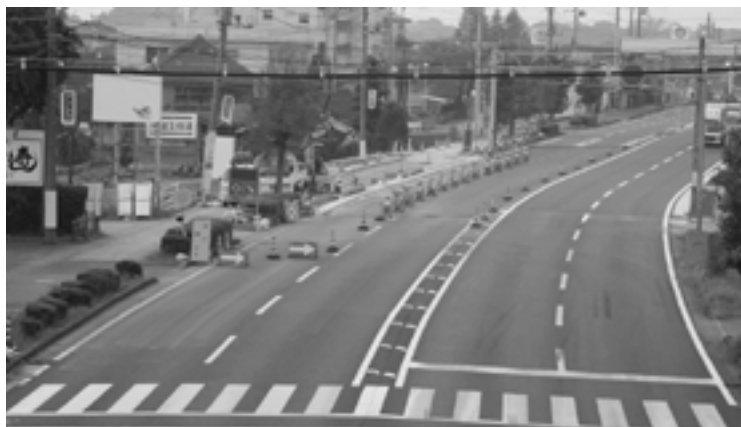
復旧工事が始まった国道125号
