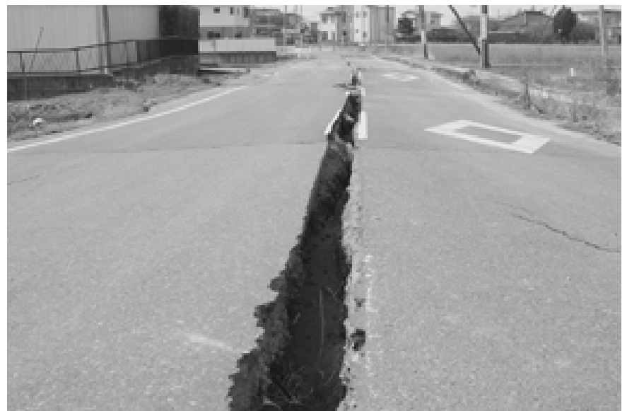
地震で損壊した道路
