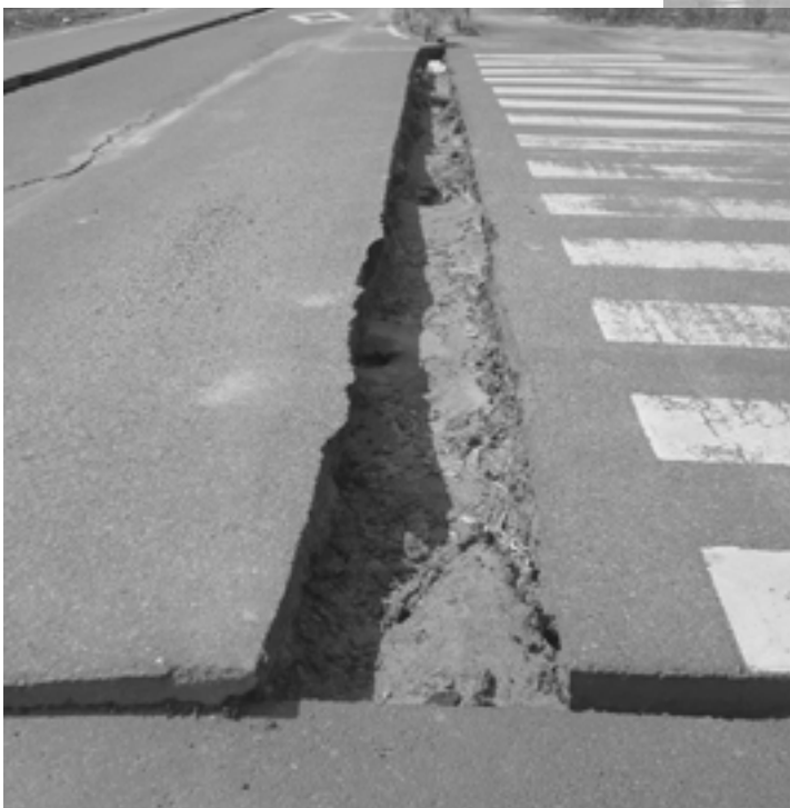
鬼怒地内（坂下橋付近）
