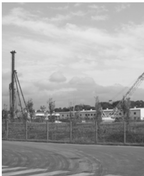
雇用創出が期待される建設中のSMC株式会社
