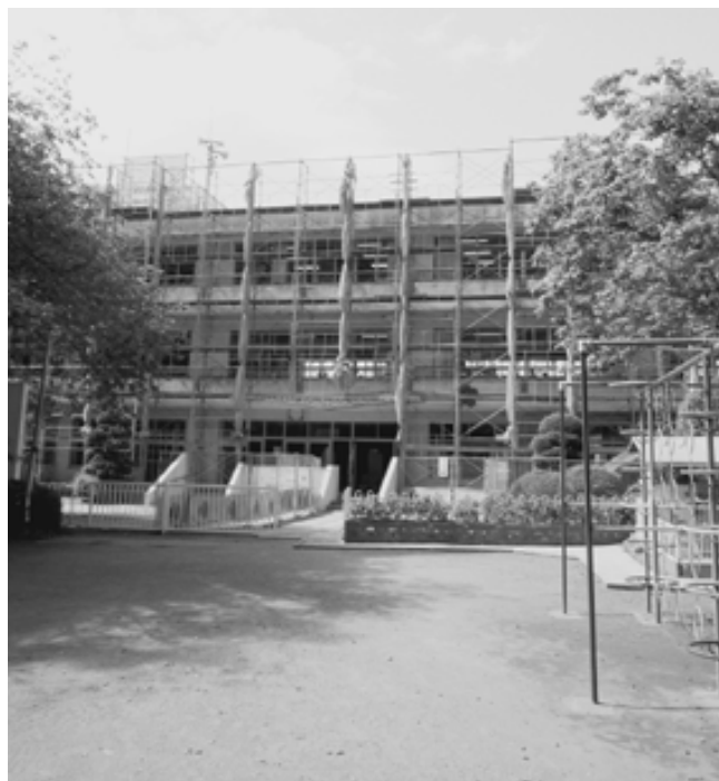
大宝小学校校舎の耐震補強が進む
