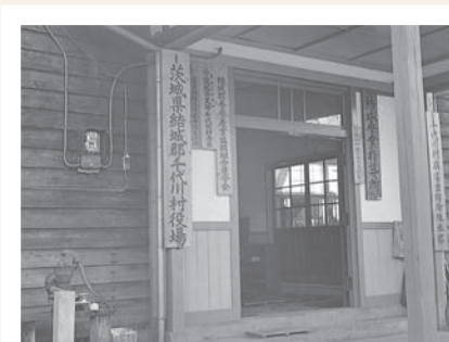
昭和34年 移転した千代川村役場
