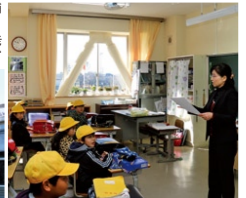
耐震ブレースで補強された普通教室(騰波ノ江小学校)
