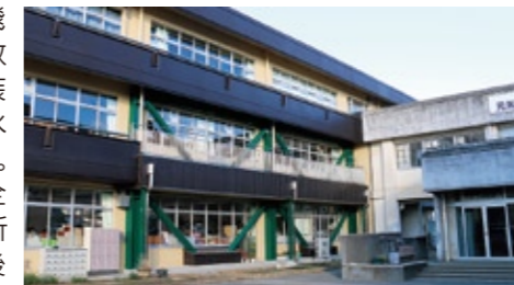
耐震補強や外壁改修された北校舎(下妻小学校)
