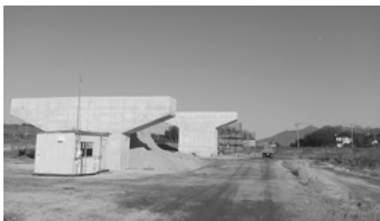
工事が進む南原・平川戸線（大宝地区）
