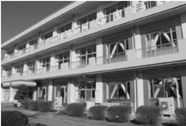
市内小中学校施設の耐震補強が進められている
