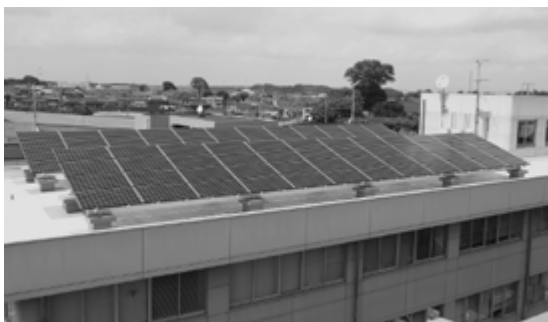
防災対策として取り付けられた市役所第2庁舎の太陽光発電
