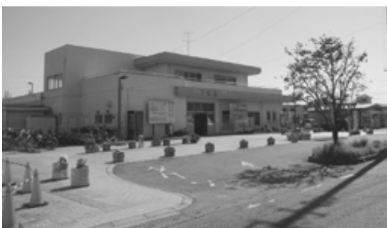
常総線の有効活用が求められている（下妻駅）
