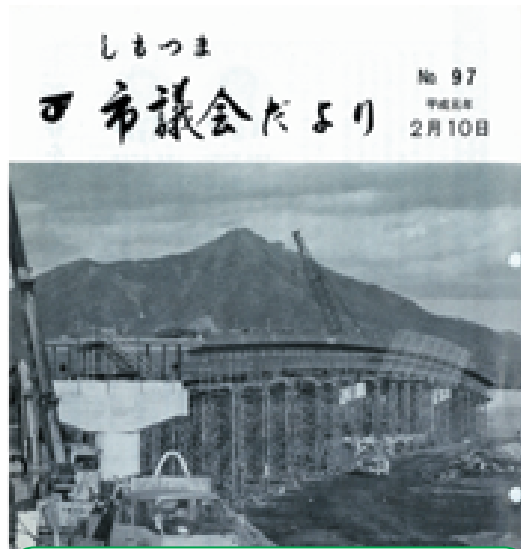
議会だより第97号表紙 平成元年2月10日発行 建設中の小貝大橋 (下田地内)
