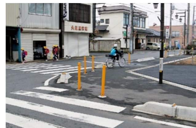
歩道が新設された市道(新町地内)
