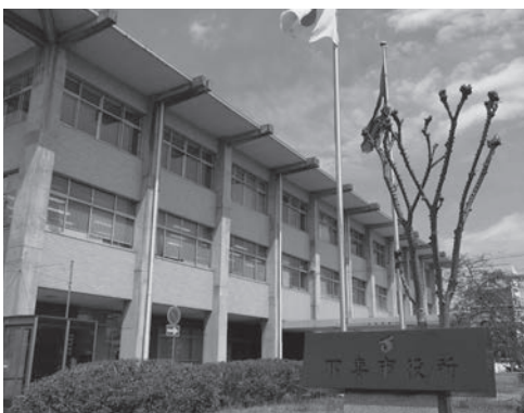
使用開始から46年が経過する本庁舎
