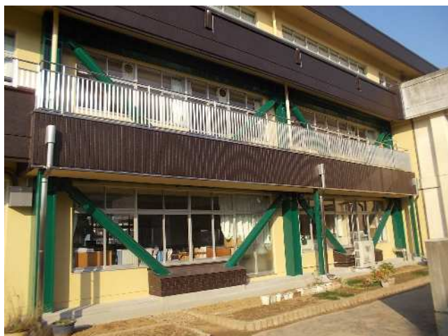
下妻小学校 耐震補強・大規模改修工事
