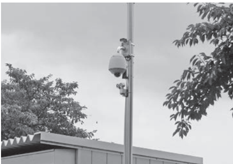
小貝川ふれあい公園での防犯カメラの設置状況
