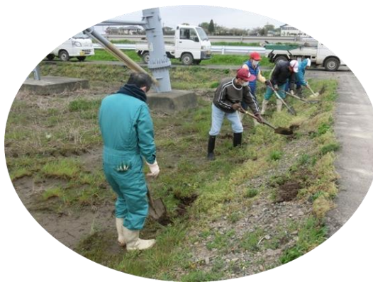
法面の初期補修 【資源向上支払(共同活動)】
