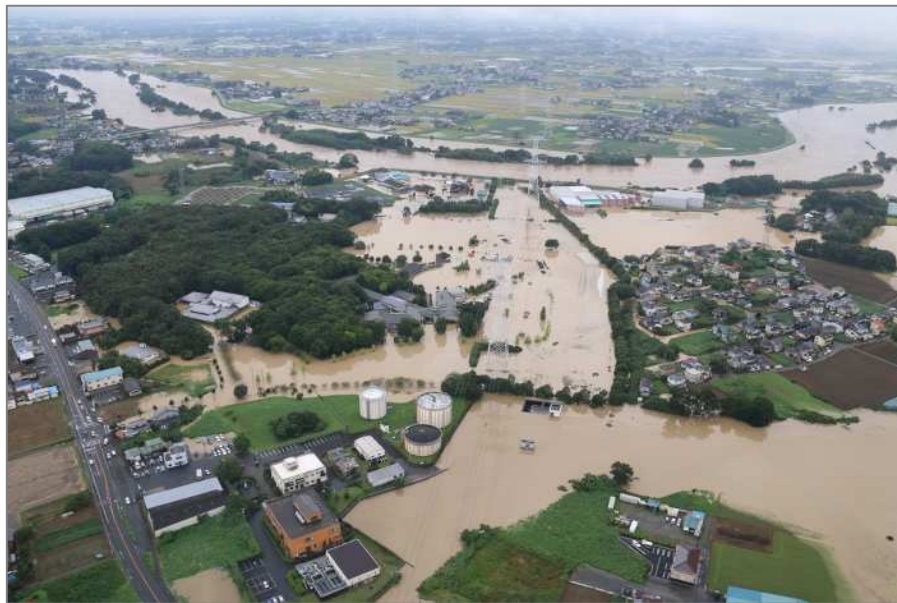
図 2.5 砂沼浄水場【浸水状況】
