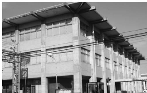
築40年を経過した本庁舎
