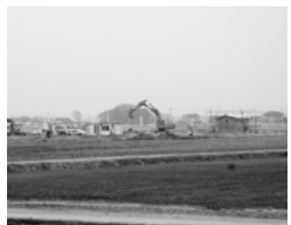
現在実施されているほ場整備事業(大宝地区)
