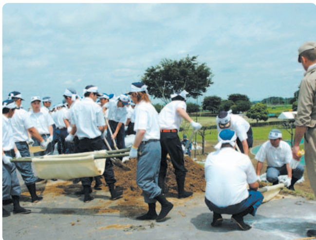
堤防天端の土のう積みの際継ぎ目に土をつめて踏み固める作業
