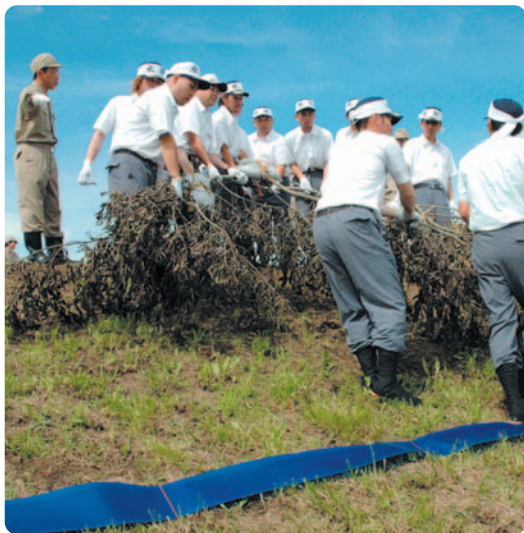
枝葉の繁茂した樹木を留め杭に結束し、崩壊面に固定させる作業
