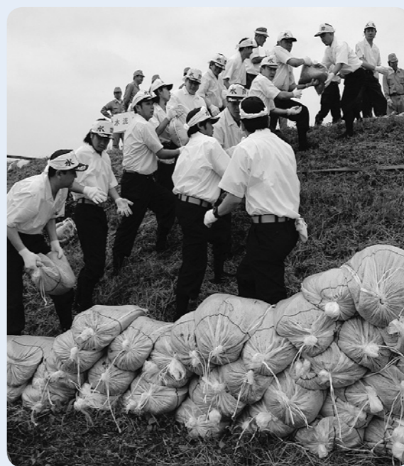
土のう袋を運び出し堤防を守る水防団員（積土のう）
