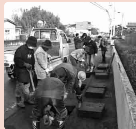
道路側溝清掃の様子
