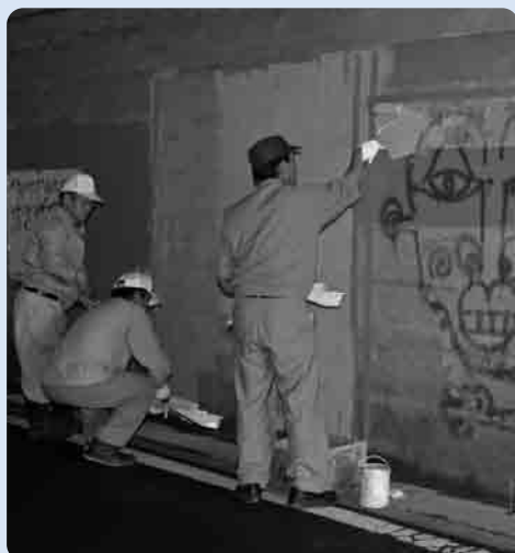
国道125号下のトンネル(峰地内)での作業
