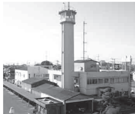
倒壊の恐れから取壊しが決定(消防署望楼)
