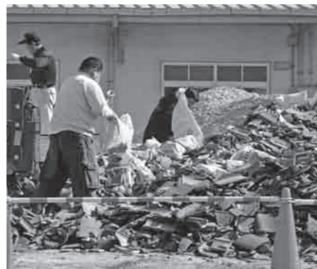
瓦礫の搬入(旧千代川中学校)
