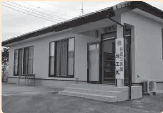
完成した新堀公民館
