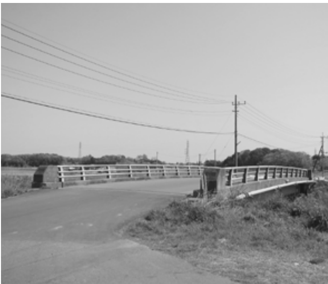
インフラの長寿命化計画が進められている
