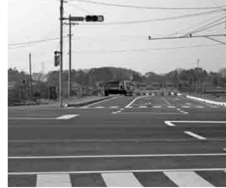
南原平川戸線と国道294号線の交差点箇所(平川戸地内)
