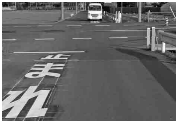
既存の市道208号線側に一時停止規制と停止線を設置
