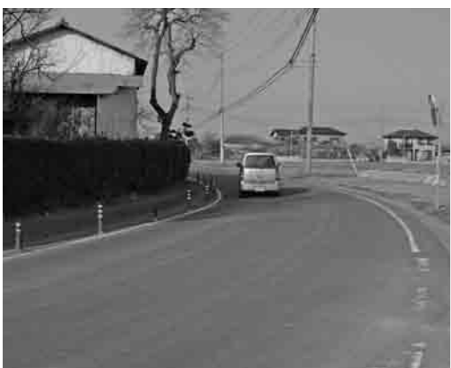
山尻地区東側のカーブ箇所
