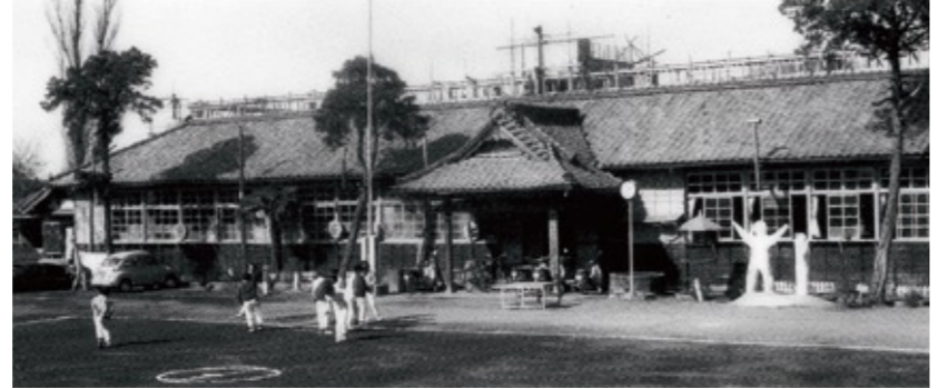
木造の旧校舎（明治44年建築）
