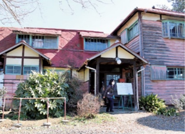
和洋折衷の外観からは、日本の木造在来工法で洋風建築をつくった際の苦労の様子が伝わってきます
