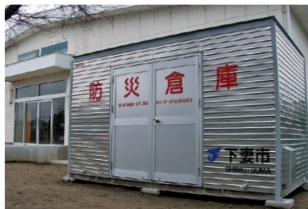
宗道小学校体育館の玄関前に設置された防災倉庫（平成26年8月設置）
