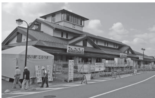
改修工事が進む道の駅しもつま
