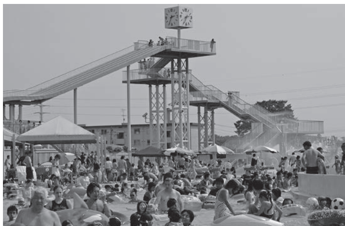
PPSにより大幅に電気料削減が期待できる砂沼サンビーチ
