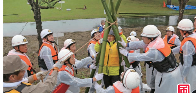
堤防法面などの亀裂拡大を防ぐ「五徳縫い」の訓練に取り組む団員たち
