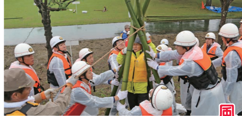
堤防法面などの亀裂拡大を防ぐ「五徳縫い」の訓練に取り組む団員たち
