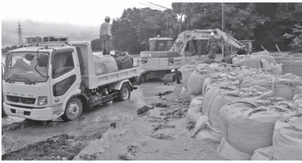
越水した前河原地区の応急復旧の様子
