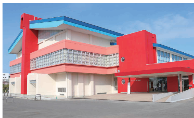
リニューアルオープンした下妻市立総合体育館(外観・南側)
