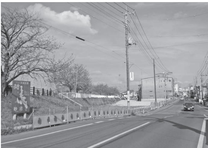
現在、工事中の(仮称)砂沼エントランス予定地
