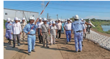
新たな堤防を歩きながら工事の説明を受ける参加者
