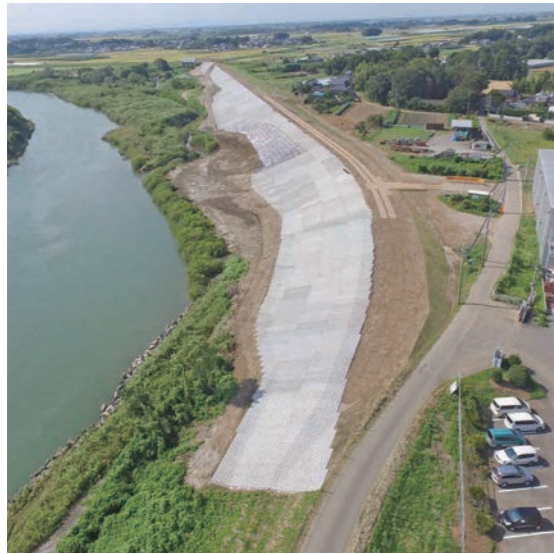
前河原地区の第1期堤防盛土の全景
