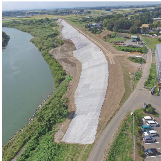
前河原地区の第1期堤防盛土の全景
