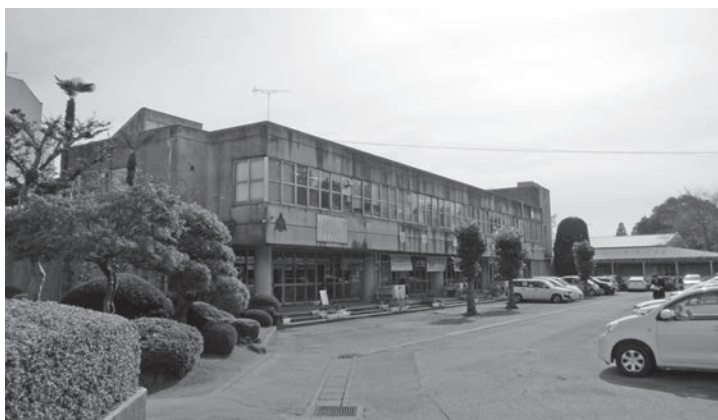
建築から40年以上が経過する下妻中学校校舎
