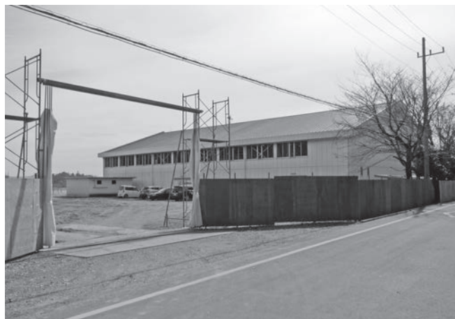
下妻中学校改築に伴い、プール施設の解体が完了している。
