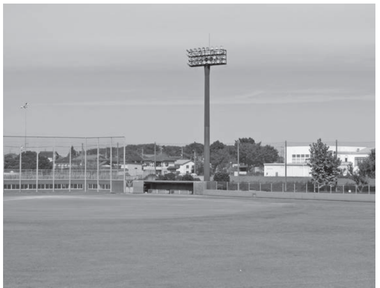
太陽光発電施設設置に伴い、一部利用制限を行っている砂沼球場
