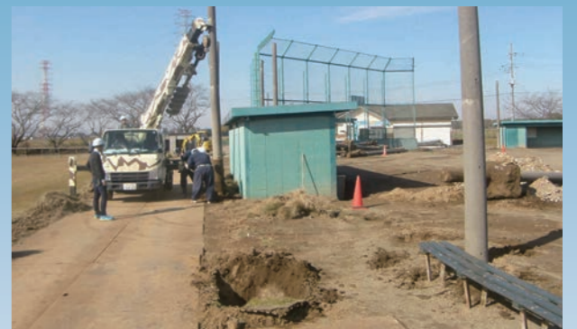
防球ネットの張替工事を行う柳原球場(A球場)
