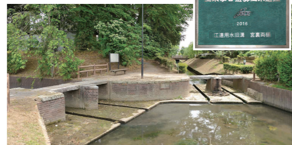
レンガ造りの水門「江連用水旧溝宮裏両樋」
