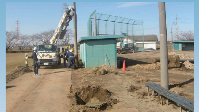
防球ネットの張替工事を行う柳原球場 (A球場)
