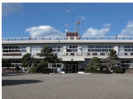
跡地利用が決定した旧蚕飼小学校の校舎
