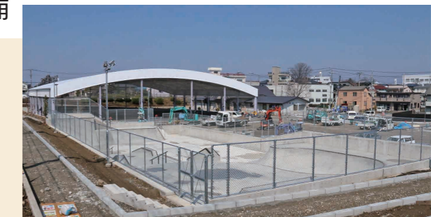
4月27日オープン予定のWaiwaiドームしもつま(建設中)
