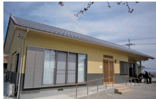
新築された松岡公民館（木造瓦葺平屋建・床面積157.33㎡）
